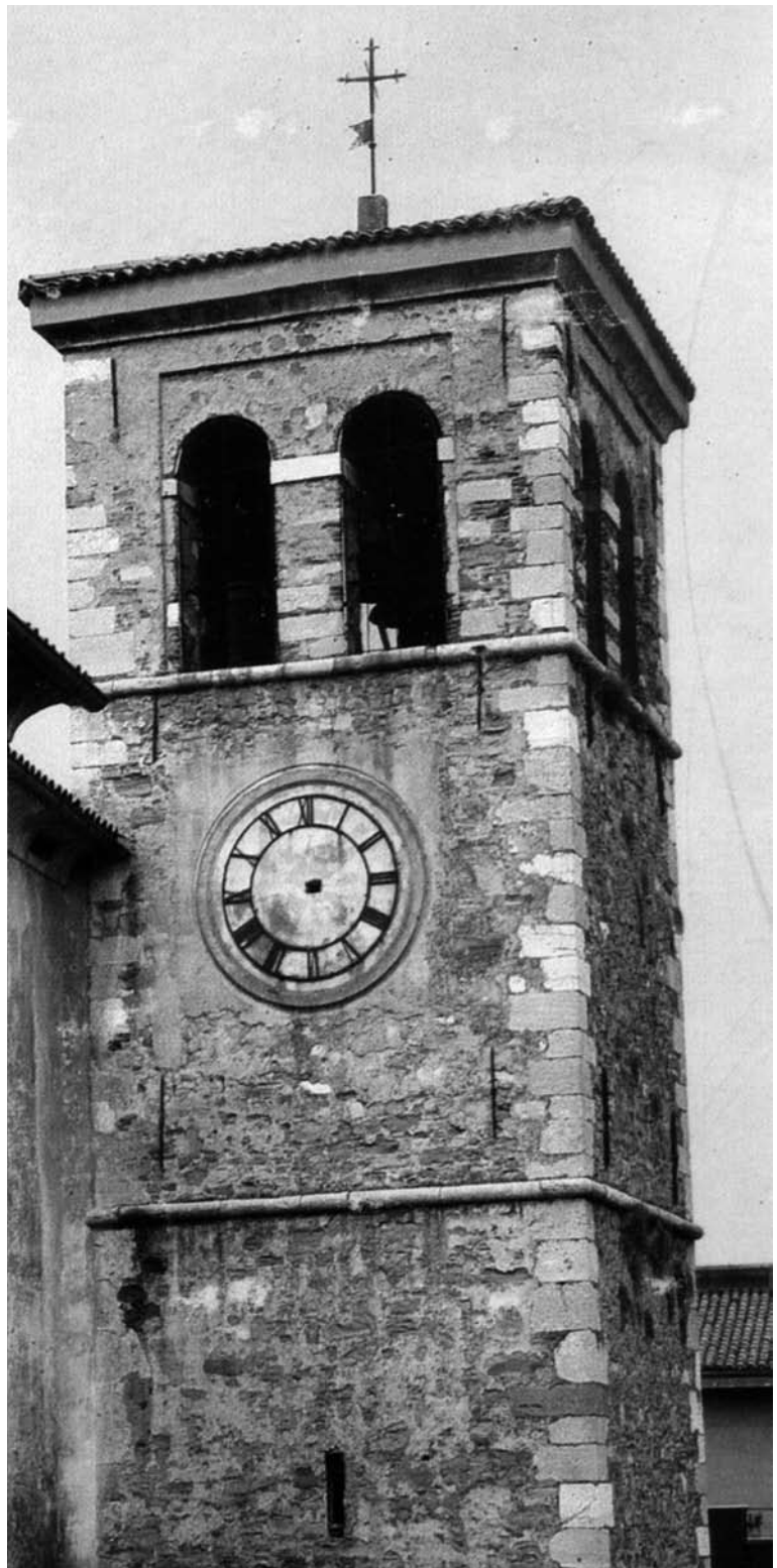
LA TORRE MEDIEVALE, RITENUTA DEL X-XI SECOLO, CHE A TUTT'OGGI FUNGE DA CAMPANILE DELLA "CHIESA MADRE" DI SAN MICHELE ARCANGELO IN CERVIGNANO DEL FRIULI (DA: SEGNI DI STORIA 1993, COPERTINA).
