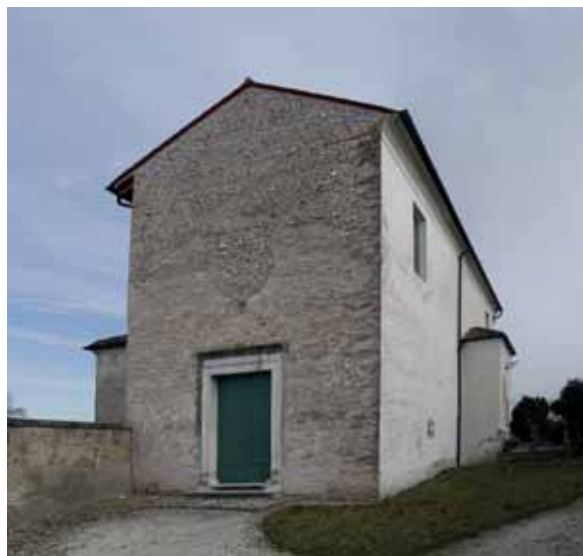
Fig. 1. Pescincanna, pieve di San Michele Arcangelo. Esterno (facciata).
