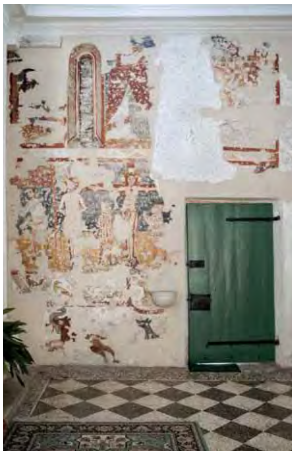
Fig. 9. Affreschi della parete sud, veduta di insieme.
