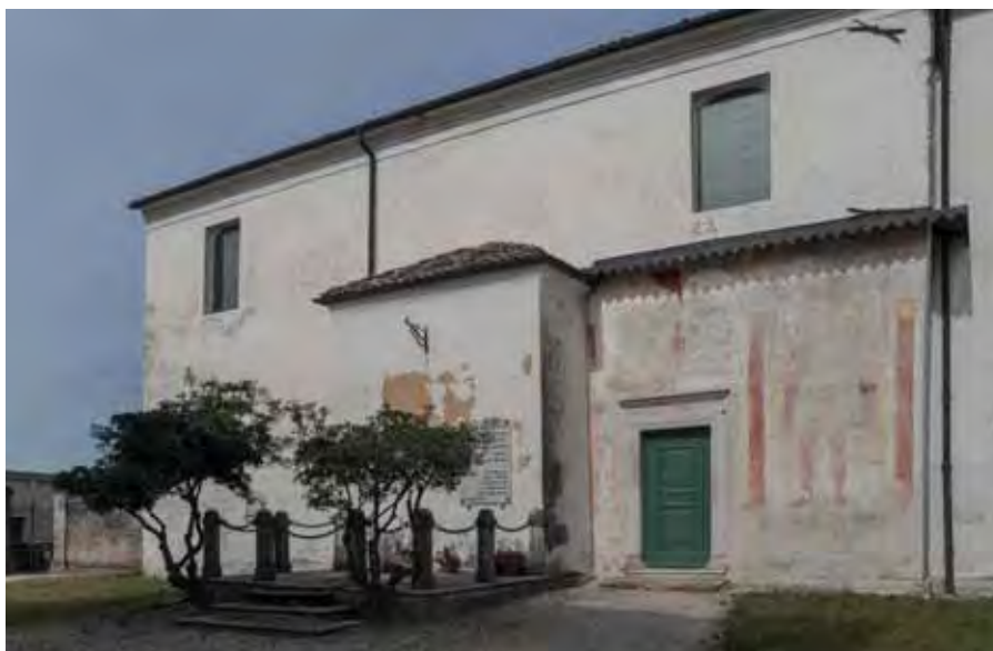
Fig. 3. Esterno (fianco lato sud).
