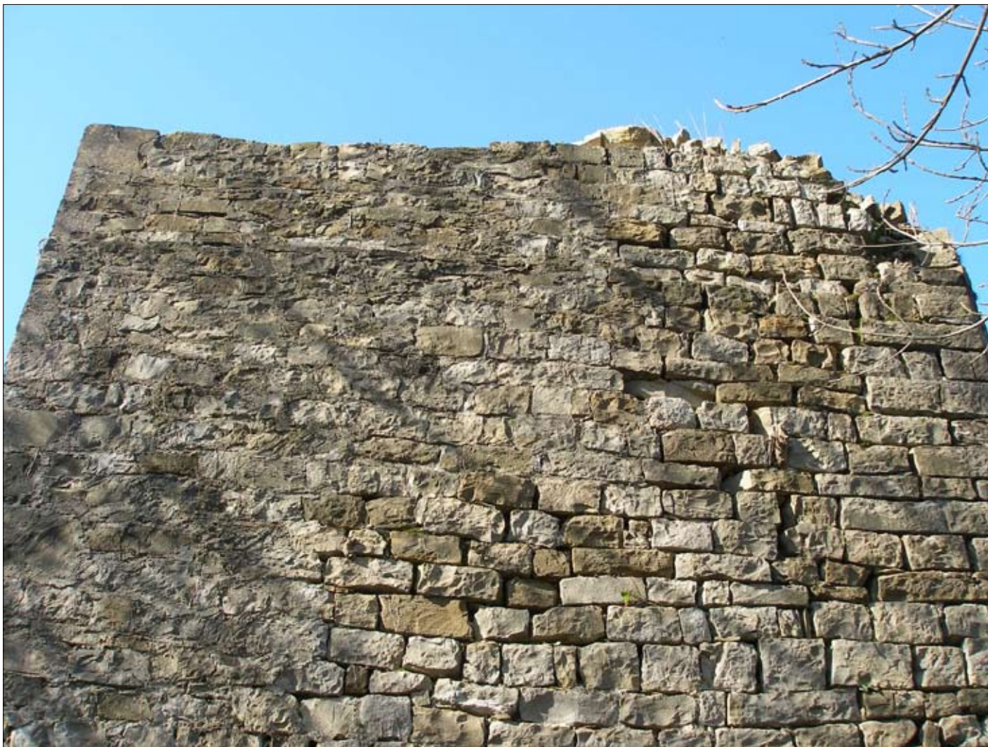
Fig. 8. La parete sudorientale del mastio. A destra la parte originaria con la tessitura muraria del XIII secolo (foto M. Lavarone).
