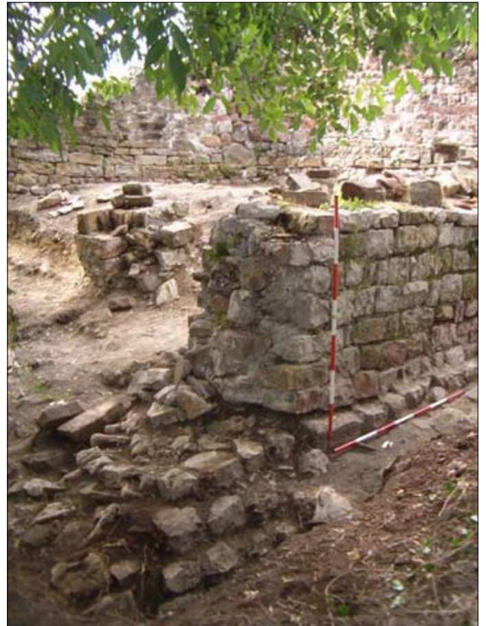
Fig. 12. Paramento murario orientale di USM 1108 (foto G. F. Rosset).
