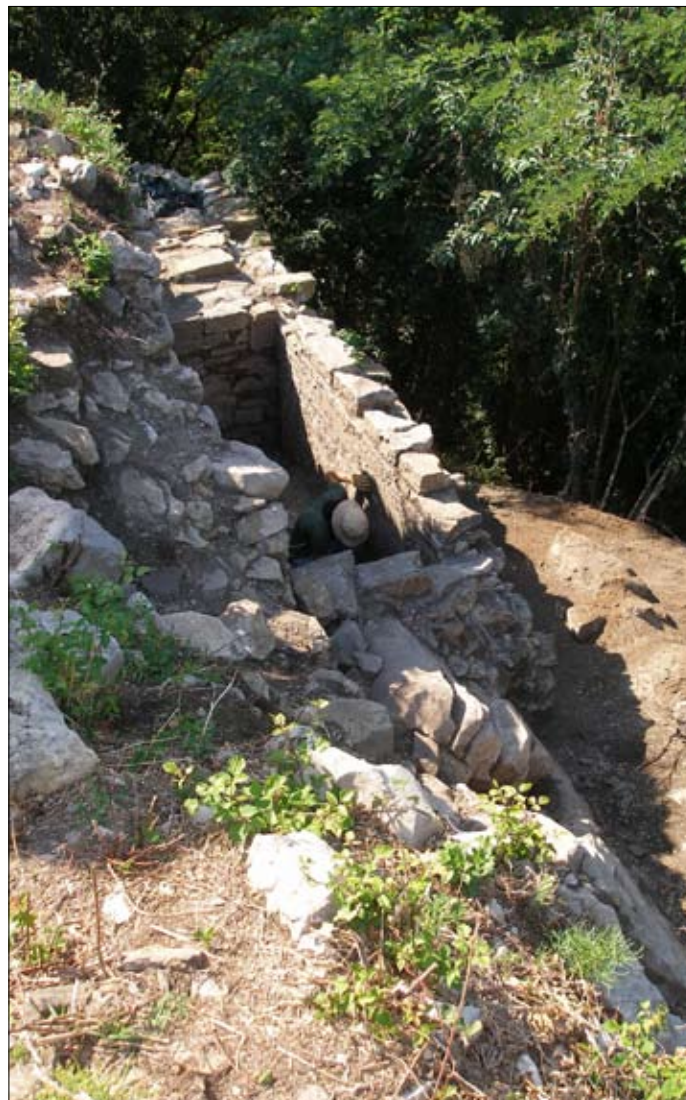
Fig. 6. La vasca US 149 che a nord si appoggia alla roccia, mentre a sud viene inglobata nel muro di fortificazione (foto M. Lavarone).
