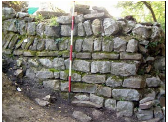
Fig. 38. Il paramento ovest di USM 1108 (foto G. F. Rosset).
