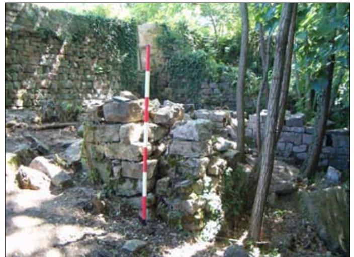
Fig. 12. Il pilastro USM 1225 visto da sudovest (foto G. F. Rosset).
