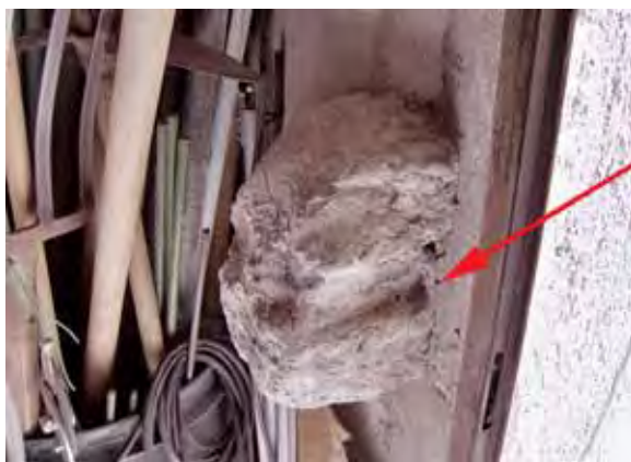
Fig. 17: Concio di pietra per l'inserimento del catenaccio (la freccia rossa indica il foro ostruito).
