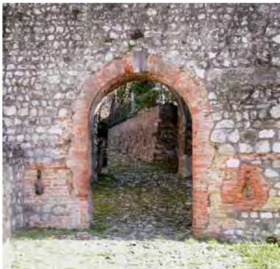
Fig. 2: Porta di Borgo o Sinagoga (ingresso esterno).
