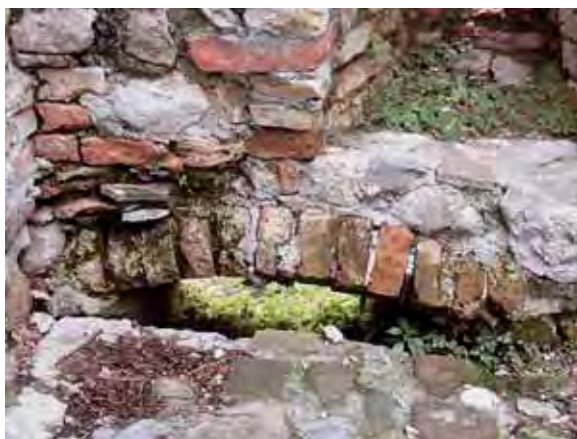
Fig. 3: Canaletta per lo scolo delle acque (lato interno).
