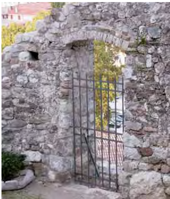
Fig. 6: Veduta interna del portello.
