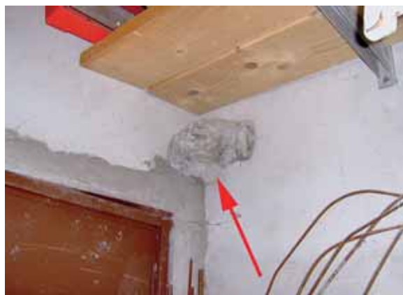
Fig. 16: Cardine in pietra che sosteneva la porta della canipa (la freccia rossa indica il foro centrale ostruito).
