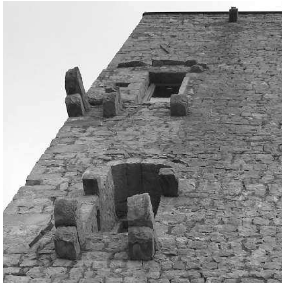
Fig. 7. Mensole inglobate nella tessitura del perimetrale occidentale del palatium e relative alle latrine aggettanti presenti in corrispondenza del primo e del secondo piano, riprese da ovest.
