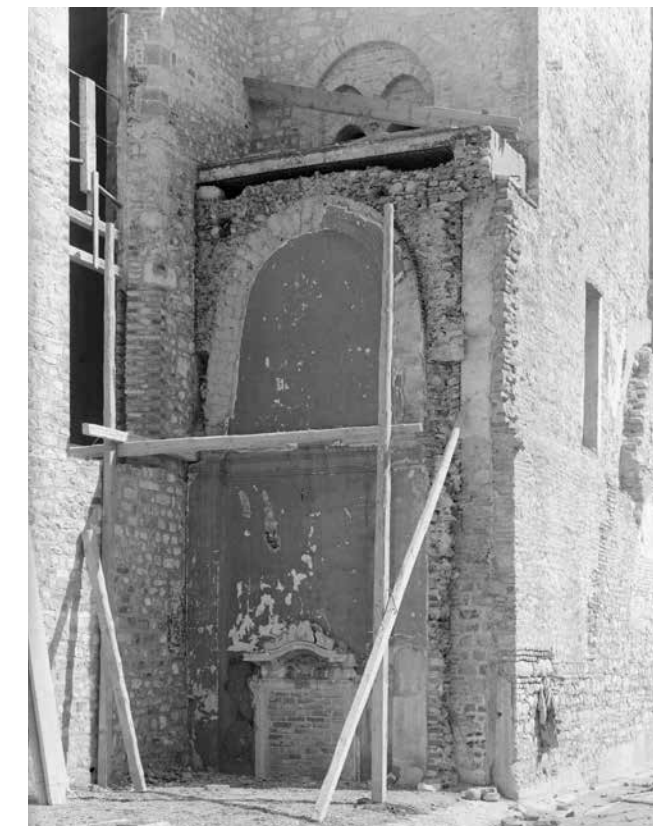
30. Angolo tra braccio destro del transetto e navata, dopo la demolizione delle cappelle laterali, settembre 1947.
