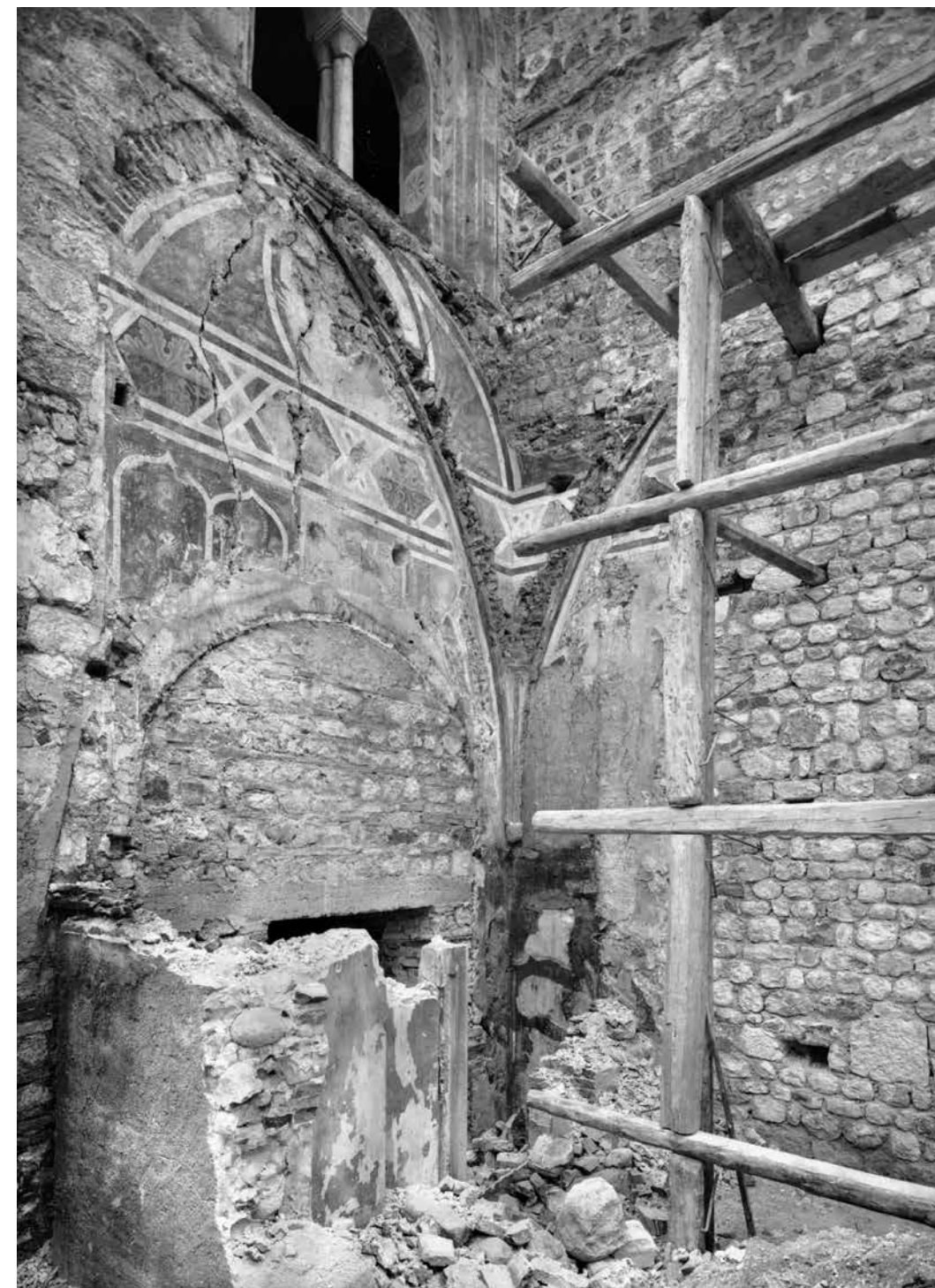
26. Angolo tra braccio sinistro del transetto e navata, demolizione della cappella laterale di San Gaetano da Thiene, già del beato Odorico da Pordenone, aprile-maggio 1948. Sulla parete del transetto sono emersi i resti della prima cappella trecentesca del beato Odorico e degli affreschi che la decoravano.
