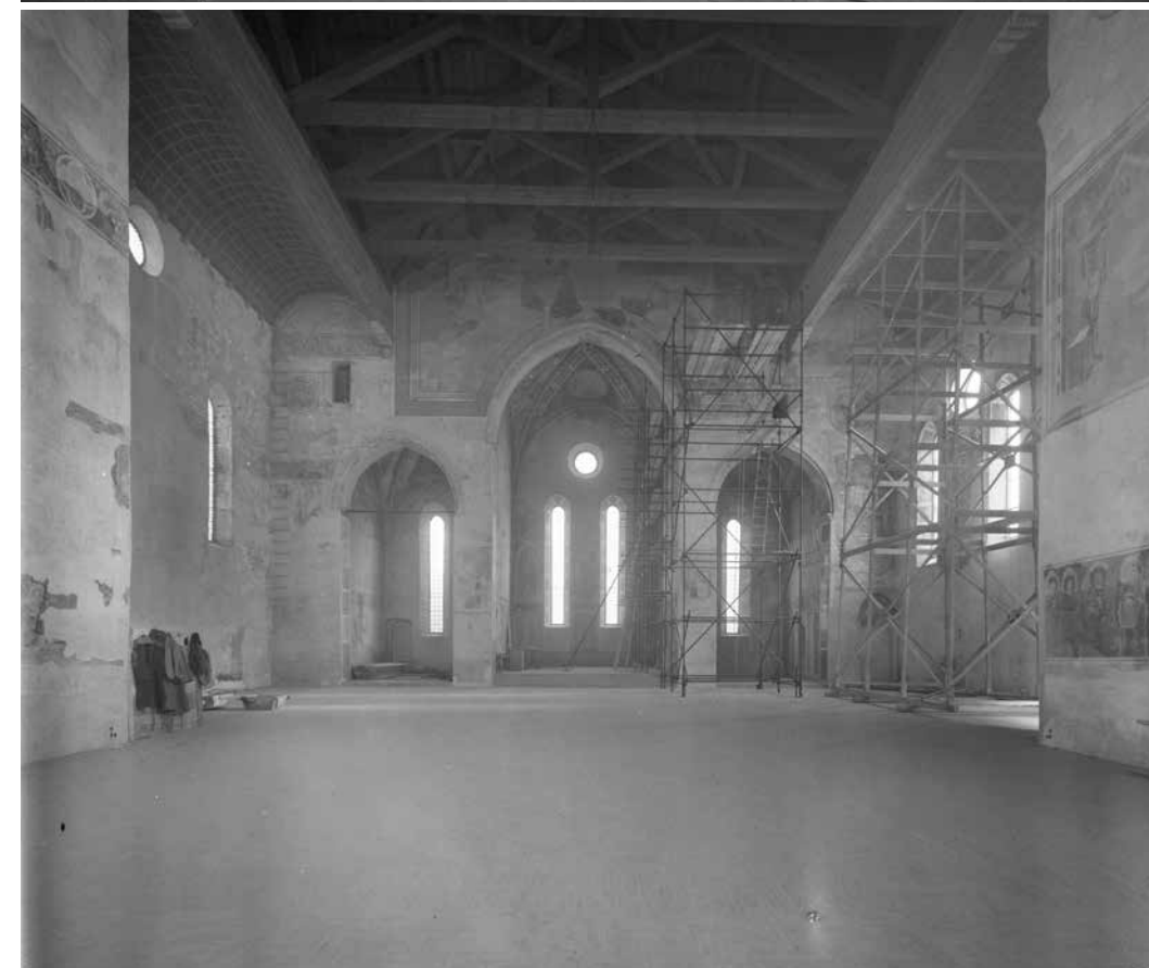
36 e 37. Le absidi e il transetto nel 1951 dopo il restauro pittorico di Mario Botter (in alto) e nel 1954 (in basso) a ripristino quasi ultimato.
