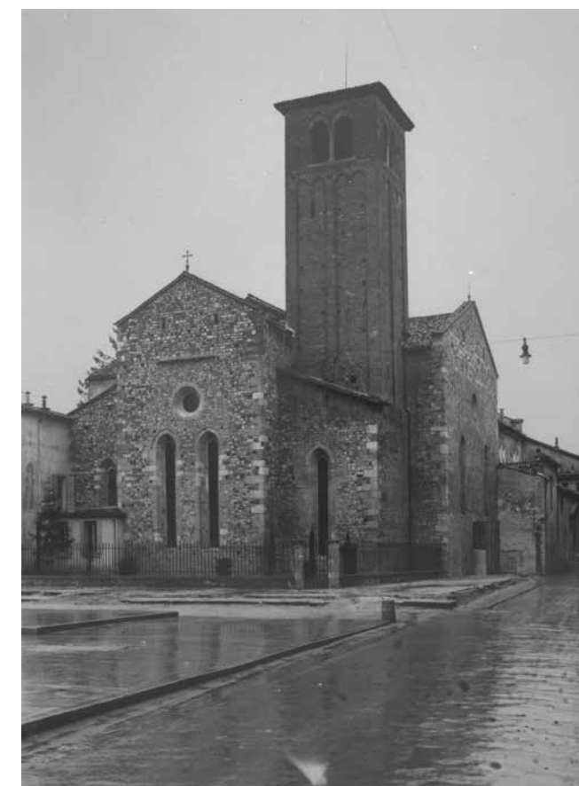
10. Veduta da est, 1937. Lungo il fianco nord è ancora visibile, contigua al transetto, la ex cappella del beato Odorico da Pordenone del XV secolo, convertita in cappella di San Gaetano da Thiene dall'arcivescovo Giovanni Girolamo Gradenigo (1765-1786).
