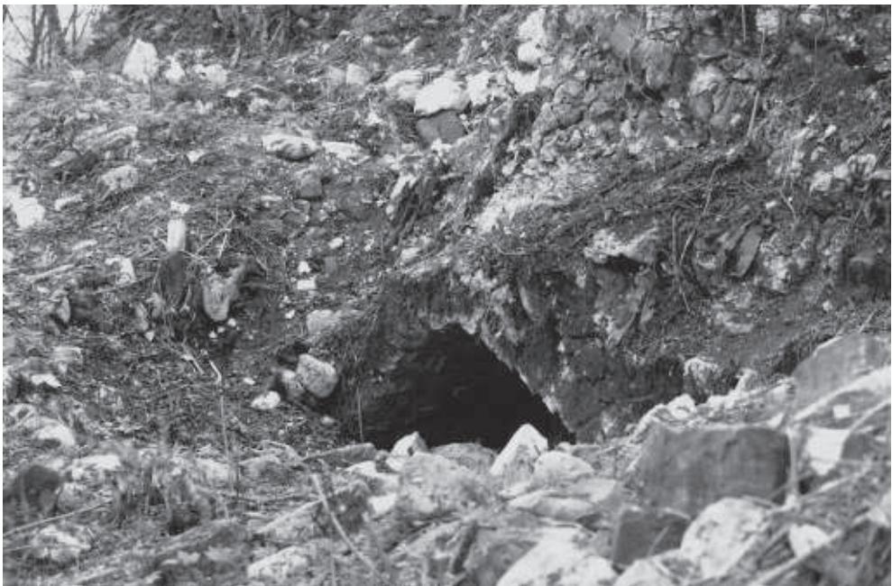
Fig. 6 – Volta di pietra USM 27 di ambiente seminterrato, ubicato nella seconda fascia di edificazione e oggi completamente sommersa dalla discarica dello scavo.
