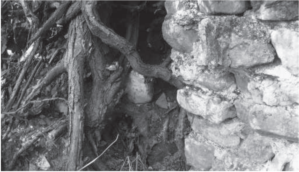
Fig. 5 – Esempio di aggressione degli apparati radicali su un tratto di muro del settore sud dell'insediamento.
