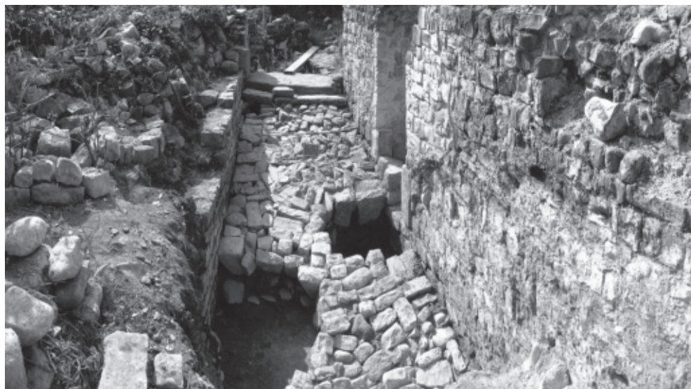
Fig. 2 – Rampa, a sud-est del mastio, di accesso al dongione di Periodo C (fine XIII-inizio XV sec.). Per la precisione la rampa, secondo la periodizzazione archeologica, è di periodo C.2, in fase con il Corpo di fabbrica 5 (Edificio D) e 6 (Edificio E).
