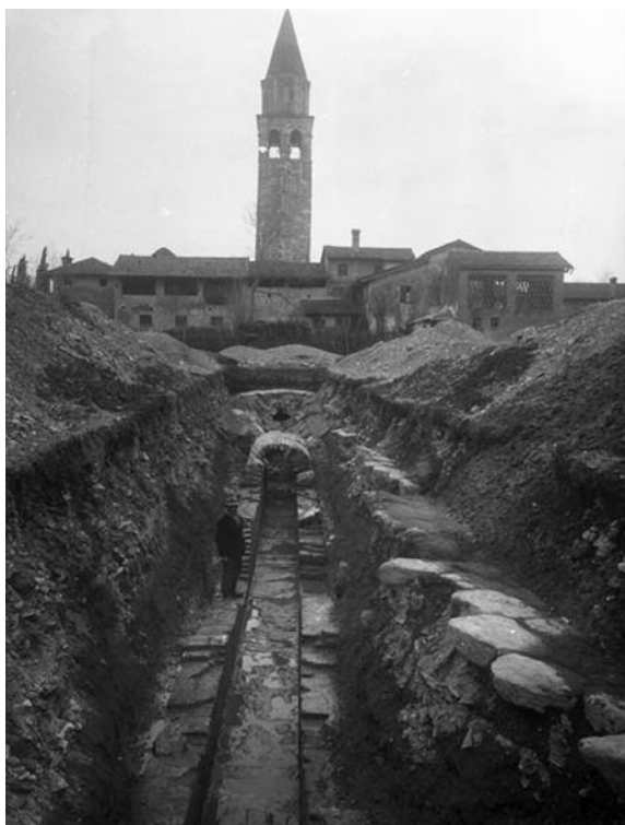
Fig. 5. Aquileia, fondi ex Cossar. Lo scavo della strada e del suo canale collettore nel 1932 (BRUSIN 1932, fig. 11).
