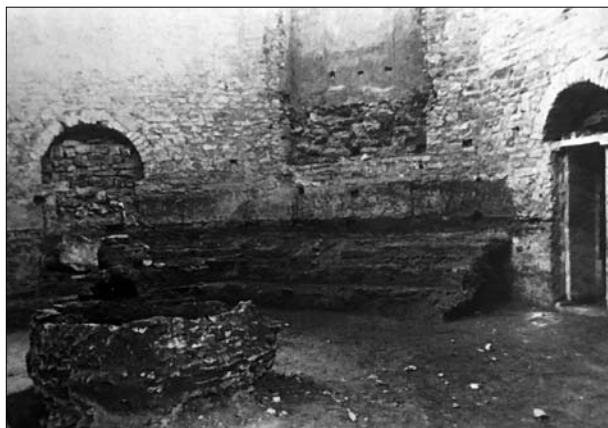
Fig. 2. Grado, battistero della cattedrale, interno durante i restauri di Ferdinando Forlati (da CASTELLAN 1988).
