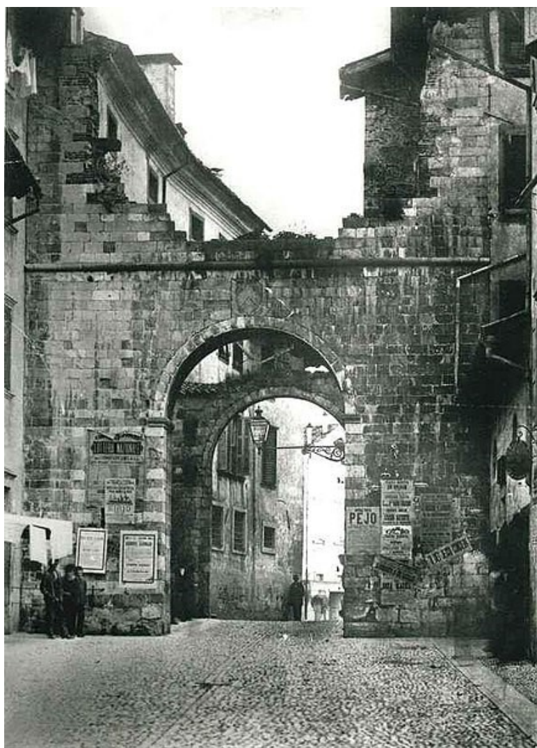
Fig. 6. L'antica porta di Grazzano, prima della sua completa demolizione.
