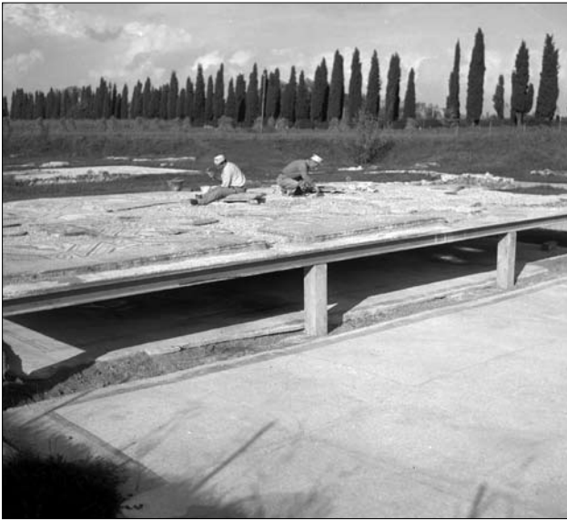
Fig. 7. Aquileia, Museo Archeologico Nazionale, Archivio fotografico, negativo n. 4802/96. Immagine databile tra il 1965 e il 1966. Ultimazione della costruzione della piattaforma meridionale. Si può notare l'assenza della piattaforma settentrionale e del rifacimento dei muretti perimetrali del mosaico sottostante.
