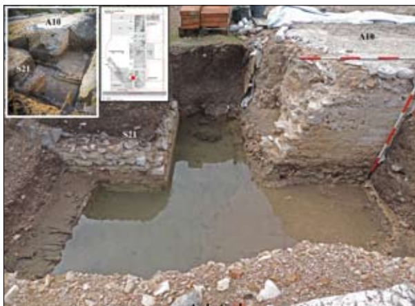
Fig. 9. Aquileia, Grandi Terme. Trincee dei muri all'incrocio tra gli ambienti S21-A10 e l'Aula Sud, da est (2017): l'acqua di falda lascia intravedere le assise rimaste dei muri e della platea di fondazione; nel riquadro in alto a sinistra, veduta da S-E senza acqua di falda. Il saggio corrisponde al quadratino nella pianta.
