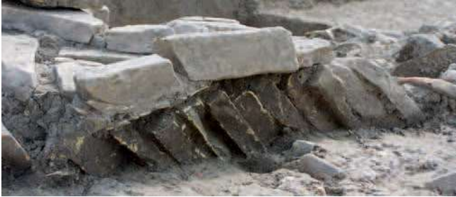
FIG. 16 | Tecnica di costruzione delle fondazioni dell'edificio rettangolare
