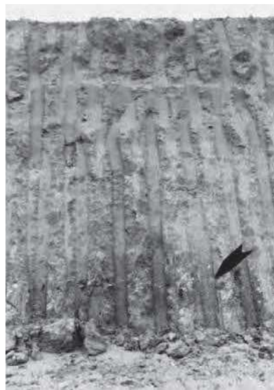
FIG. 3 | Antico livello di frequentazione venuto alla luce a oltre 4 m di profondità in una delle sezioni di scavo aperte nel 1993 per la realizzazione del ponte sulla SP 7 (foto di Benvenuto Castellarin)
