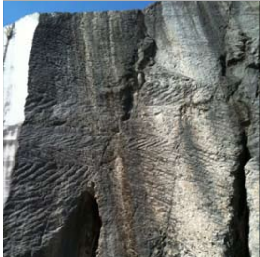
Fig. 3. Aurisina. Segni di estrazione manuale su un fronte di cava.
